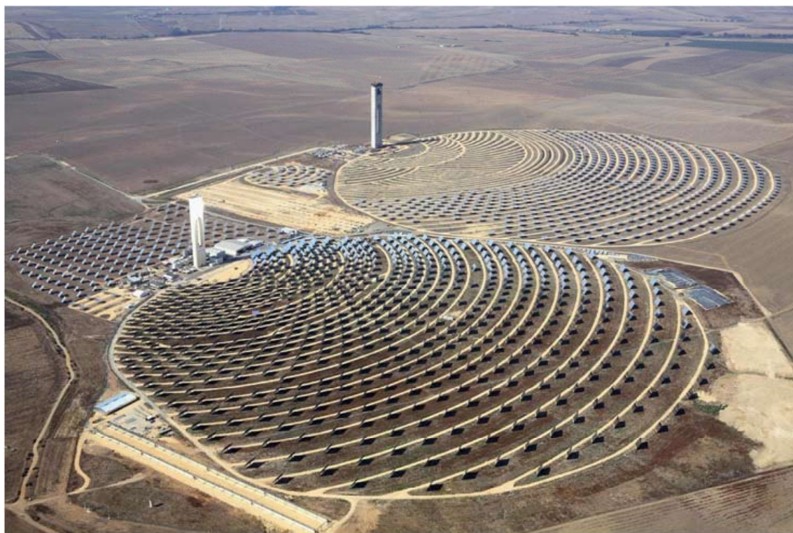
Figura 20. Planta solar de torre central PS10 en operación (frente) y planta PS20 en construcción (al fondo). Foto: Abengoa Solar.
