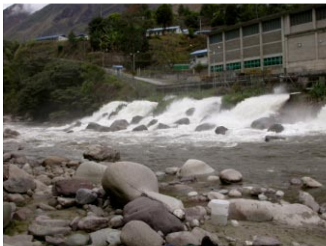
Figura 1. Hidroeléctrica Yaupi ubicada en la zona de selva alta del departamento de Junín.
